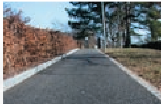
un chemin en bitume perméable (cimetière de Beauregard, Neuchâtel)
